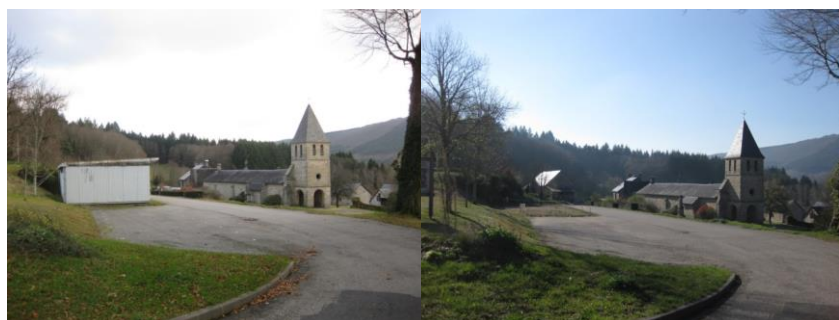
Démolition d'un ancien préfabriqué en face de l'église de Veix
