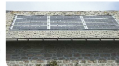
Intégration en toiture
