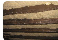
laine de chanvre sur plafond
