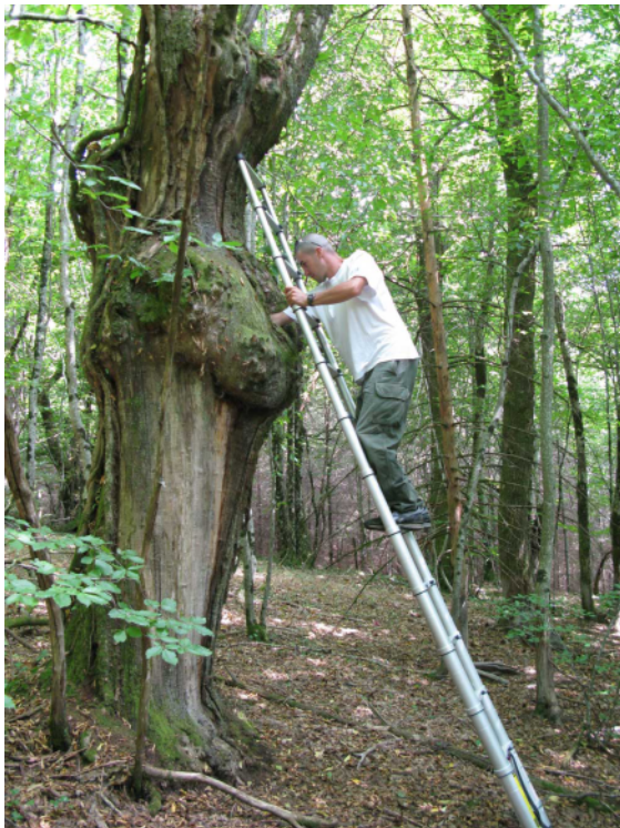
Figure 2 : Inspection d'une cavité haute à l'aide d'une échelle pliable. Cliché L. Plas
